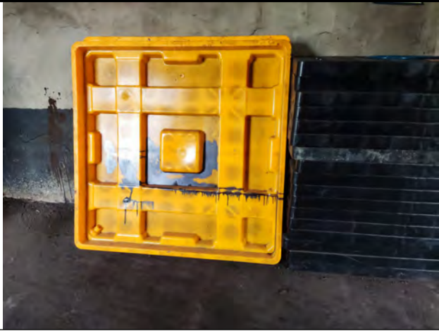
防泄漏托盘（危废暂存间）
