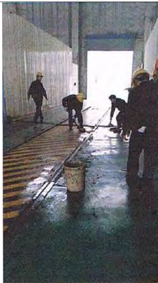
(10) 现场彻底清理
