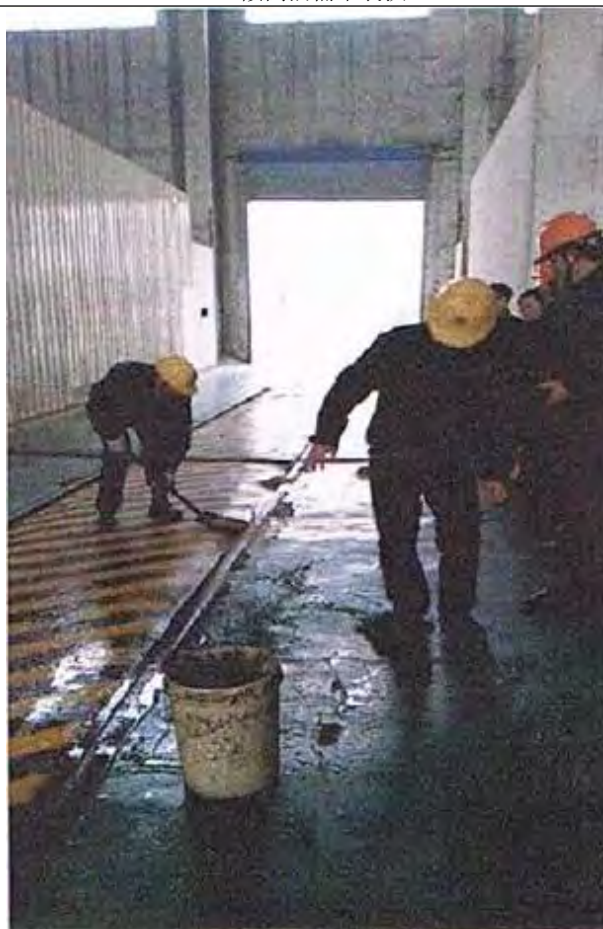
(10) 现场彻底清理
